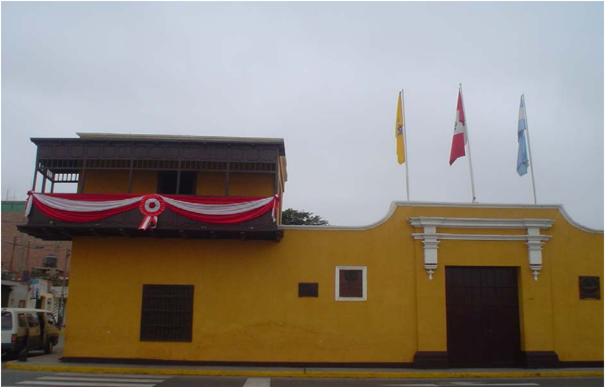
FOTOGRAFÍA Nro 9: Vivienda en donde San Martín estableció su cuartel general en Huaura. Se puede ver el Balcón de la Independencia.
